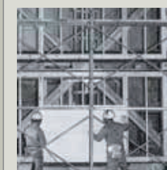
試験体(施工中)全景
